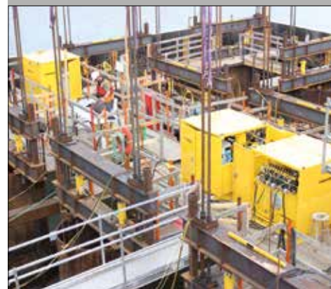
▲ Pompa idraulica customizzata per un sistema di montaggio dell'impalcato di un ponte.
